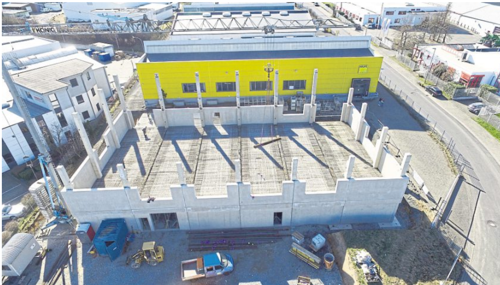
Derzeit entsteht ein neues Gebäude am Hauptsitz des Unternehmens Krups Automation im Industriegebiet Urbacher Wald. Das dreistöckige Gebäude mit Produktionsflächen und Büroräumen soll noch in diesem Jahr komplett fertiggestellt sein. Foto: Krups Automation
